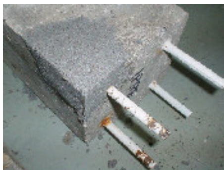
Figura 2. Estructura reparada con mortero.
