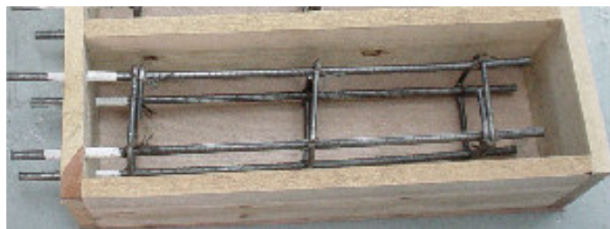
Figura 3. Armado de cimbra para cada una de las vigas.
